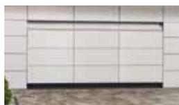
Ворота поставляются с полотном из алюминиевых рам без заполнения. Предназначены для последующей установки на полотно вентилируемых фасадных систем с помощью крепежа, поставляемого в комплекте с воротами. Благодаря такой конструкции достигается установка фасадных панелей на полотно ворот вровень с панелями на прилегающих стенах и здания и создается эффект единого пространства.
